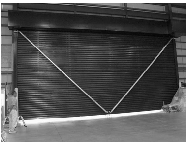
この教訓を生かし、シャッターの耐風性能を強化すること。補強材を取り付けることにした。シャッター上部の角から中央にかけて、開閉に合わせたV字型の補強材を追加
