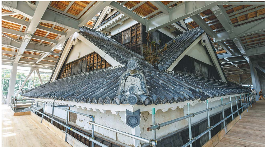
解体工が進む宇土櫓五階櫓
